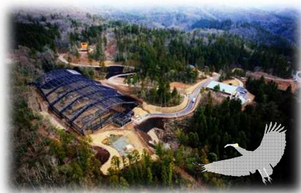
順化ケージとステーション全景
